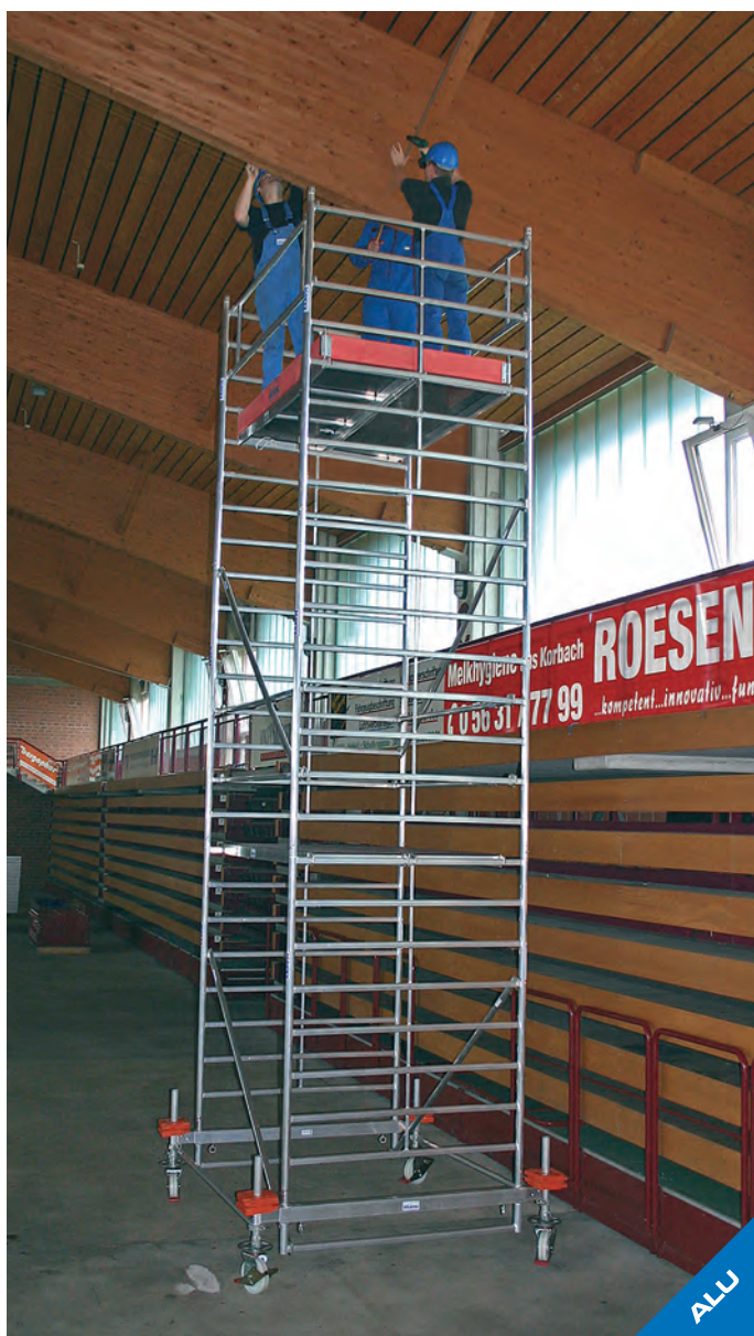
Állványmező hossza: 2,00 m – Mező szélessége: 1,50 m
