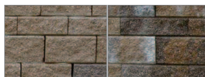
Kerítés hidrofobizált anyagból
