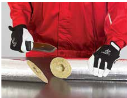
5. kép – A csőhéjat két 45°-os elemre vágjuk
