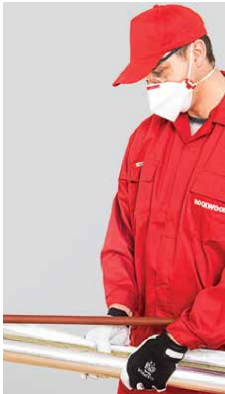
1. kép – A szigetelés felhelyezése
