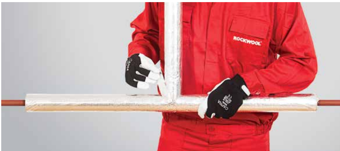
19. kép – Illesztések összeragasztása öntapadó alumínium szalaggal
