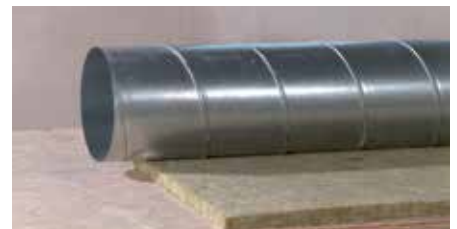
1. lépés – A szigetelés pontos méretre vágása
