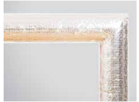
9. kép – Elkészült könyök szigetelés két elemből
