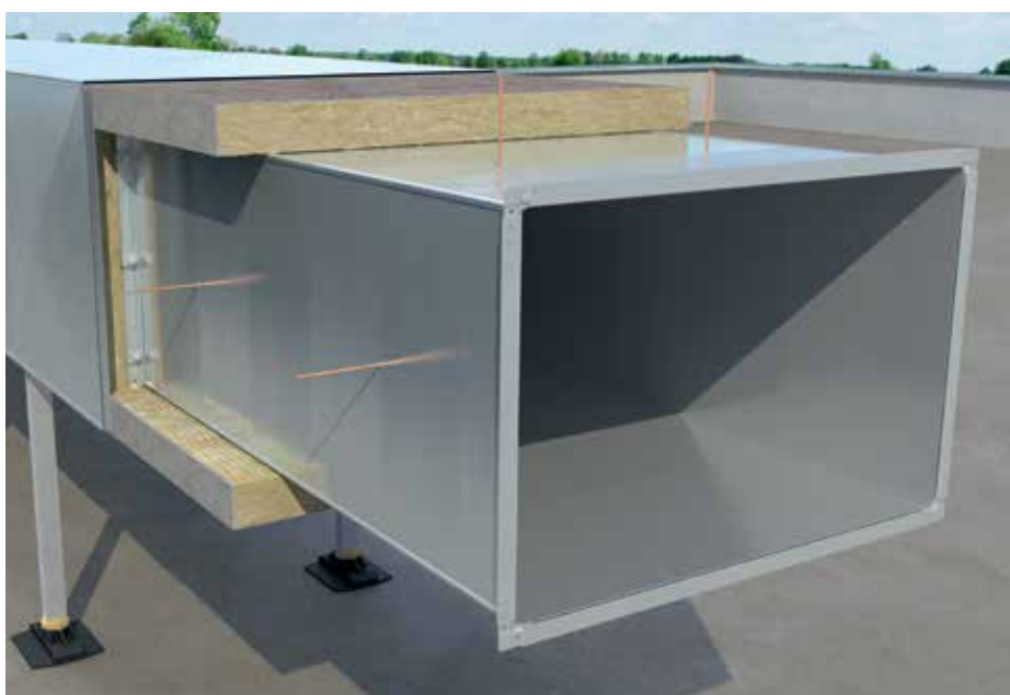
Kültérben vezetett légcsatornák szigetelését az időjárás hatásaitól védő burkolattal kell ellátni, pl. lemezburkolattal.
