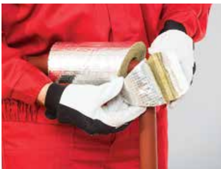
11. kép – Egy szegmens felhelyezése
