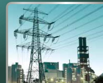
Erőmű építés és karbantartás
