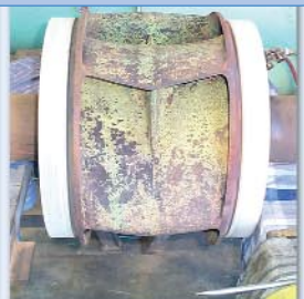
A fedél és a bronz járókerék a felújítás előtt. Az első lépés SA-3 minőségű szemcseoszórás a 75 µm-es felületi profil biztosítása érdekében.
