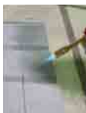
4. ábra: A filces lemezek végein a kapilláris vízfelszívódás megakadályozása (a) helyszínen égetéssel vagy (b) vízes bázisú lakkfestéssel
