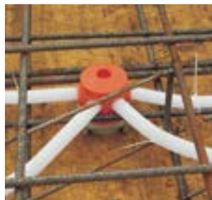
A vízszintes zsaluzaton való alkalmazás példája.
