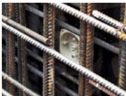
A zsaluzatra erősített KBV fedél.
