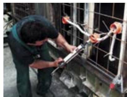
Az átvezetések tömítése (gitt).
