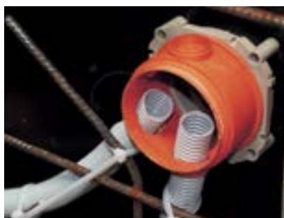
A KBT palástjába szerelt hajlékony csövek.
