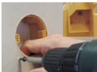
4) A doboz rögzítése önfúró csavarral. A kis képen a dobozban a csavar számára kialakított hely.
