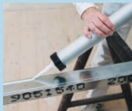
Knauf Trennwandkitt az UWV profil hátoldalán
