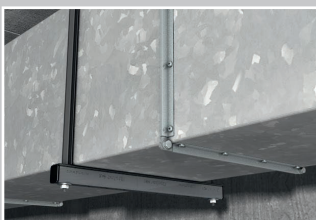
FLS szerelősín, EM3 1 gumibetét
