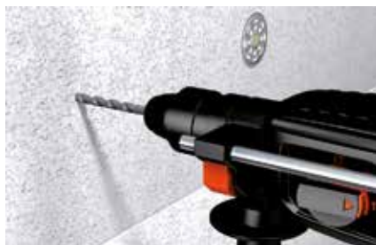
Polisztirol rögzítése téglafalhoz
