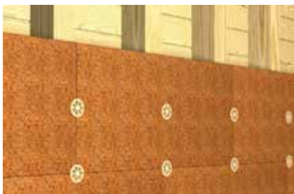
Fa szálak táblák rögzítése tömör fánál
