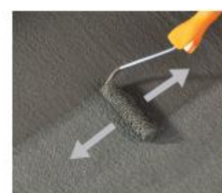
12 – Hordja fel a Folyékony vízszigetelés második rétegét.
