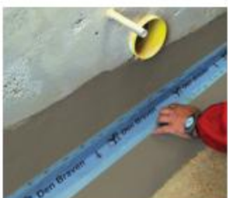
10 – Illesse bele az első bevonatrétegbe a Tömítőszalagokat és a Saroktömítéseket.
